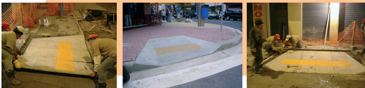
Promoção de acessibilidade: construção de calçada acessível
