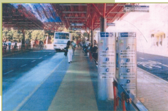
Terminal de ônibus urbano de Franca - Painel orientativo acessível e piso tátil
