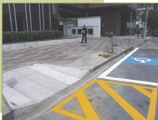
Foto 6 - Rampa de acesso a veículos credenciados - Belo Horizonte, 2006.
