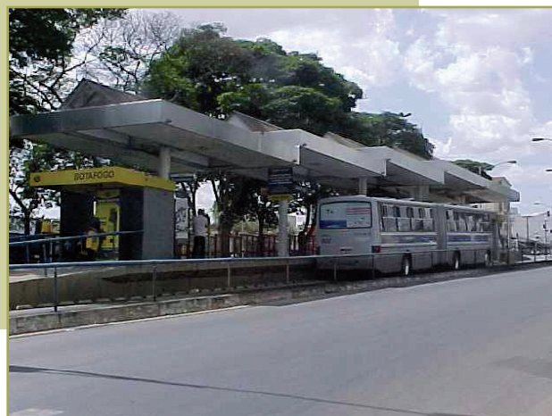
Foto 2 - Pista exclusiva para ônibus com plataforma elevada para embarque em nível - Goiânia, 2004
