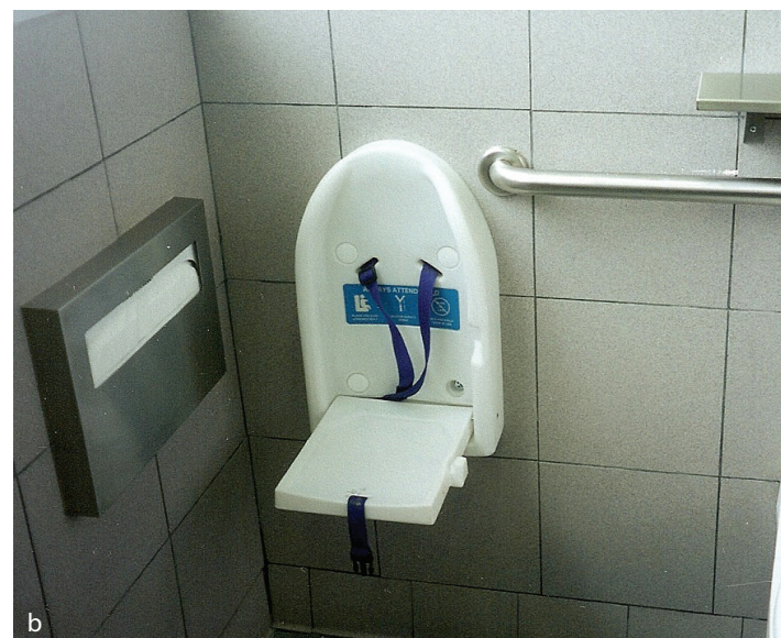
Fig. 14a. A pessoa em cadeira de rodas fica impossibilitada de usar o lavatório, se esse não foi projetado com o espaço adequado para aproximação e altura livre mínima. Fig. 14b. Presença de cadeirinha para bebê permite que a mãe utilize o sanitário sem o auxílio a outra pessoa.
