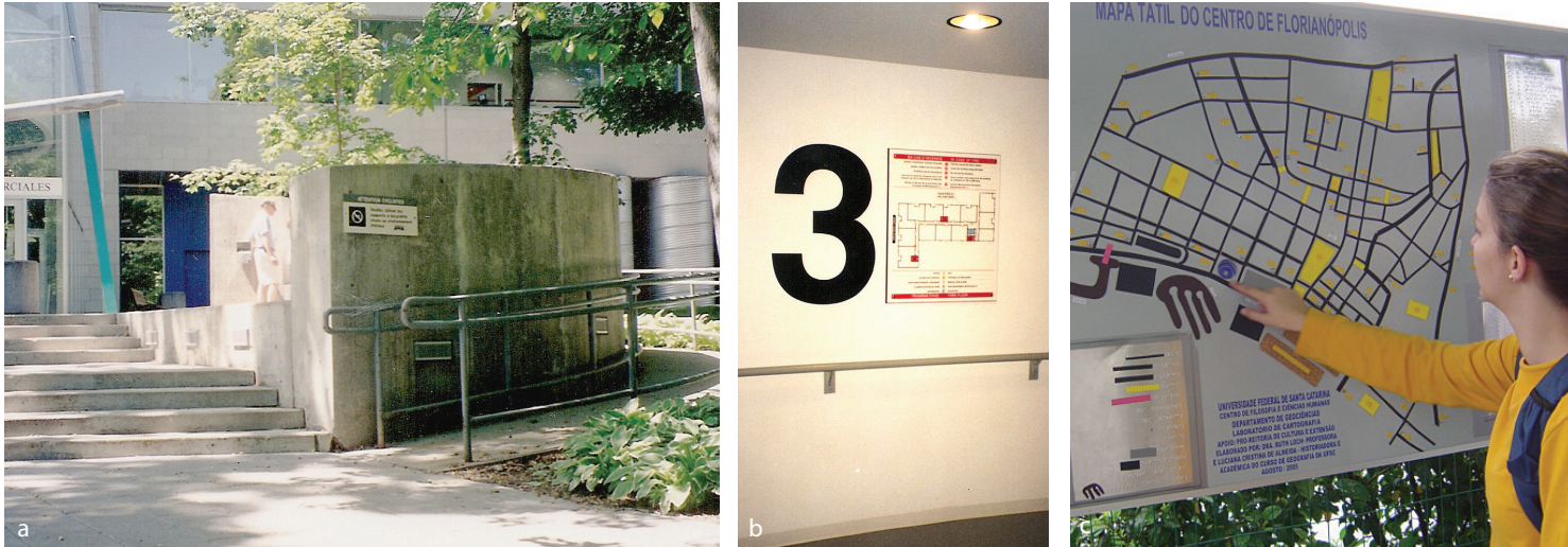
Fig. 3a, 3b e 3c – À esquerda, exemplo de entrada acessível de um edifício público, onde se pode observar a igual importância concedida à rampa e à escada. No centro, circulação interna, onde há clara identificação, no mapa, do pavimento, assim como dos serviços e direções existentes (pictogramas). À direita, presença de mapa tátil informa o sistema viário de um centro urbano.
