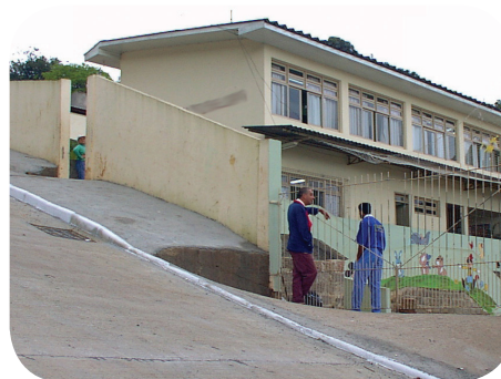
Entrada de escola em rua extremamente inclinada Fonte: Acervo autoras.
