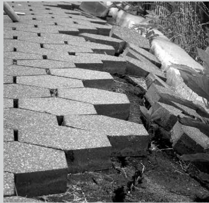
Paver é o nome dado a cada uma das peças pré-moldadas de concreto destinadas à pavimentação intertravada. Foto: By Jim.henderson (Own work) [CC0], via Wikimedia Commons).
