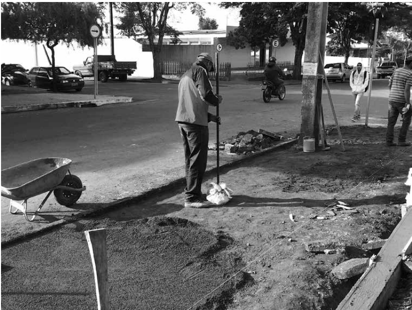
Trabalhos de execução da calçada da Rua R. Ferrari (Abril de 2016)
