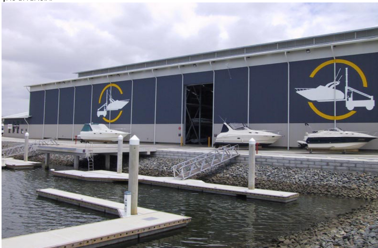
FIGURA 18: ESTRUTURAS E CONTENÇÕES: ESTRUTURA METÁLICA NO GALPÃO E DRYSTACK; ESTACAS DE CONCRETO NAS DOCAS FLUTUANTES; TALUDE PROTEGIDO POR PEDRAS DE MÃO (RIP-RAP) NA CONTENÇÃO DA BACIA.
