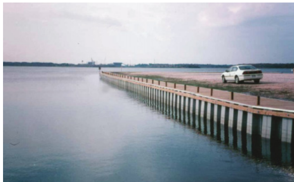
FIGURA 17: EXEMPLO DE CONTENÇÃO POR ESTAQUEAMENTO
