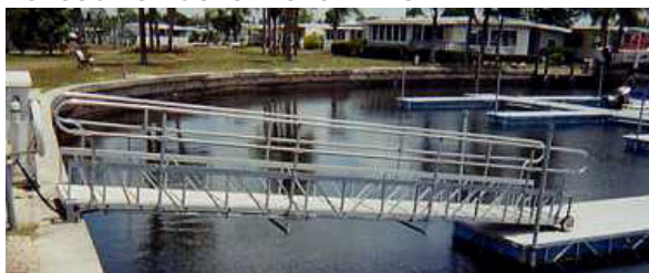
FIGURA 12: GANGWAY - RAMPA ARTICULADA PARA ACESSO ÀS DOCAS FLUTUANTES
