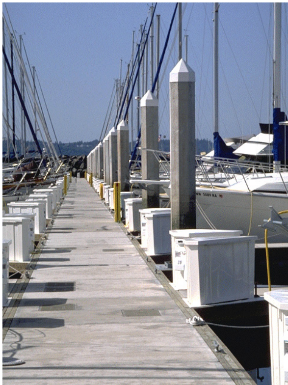
FIGURA 14: DOCAS FLUTANTES DE CONCRETO
