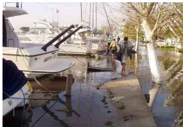
FIGURA 6: ESTRUTURAS MAL PLANEJADAS
