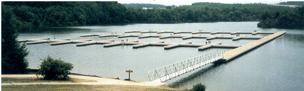
FIGURA 11: CODORUS STATE PARK NA PENNSYLVANIA (328 VAGAS, INSTALADAS EM TRÊS SEMANAS)
