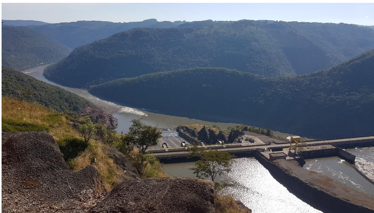
Figura 45. Usina Hidrelétrica de Barra Grande – Anita Garibaldi
